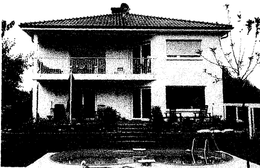
Auch beim Neubau von Einfamilienhäusern, wie hier in Mahlow, sind die Planungs- und Überwachungsleistungen des Büros Loyal gefragt.
